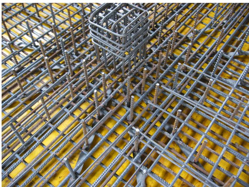
*Bild 5:* Eingebaute HFV-Leisten der Platte 30-III
